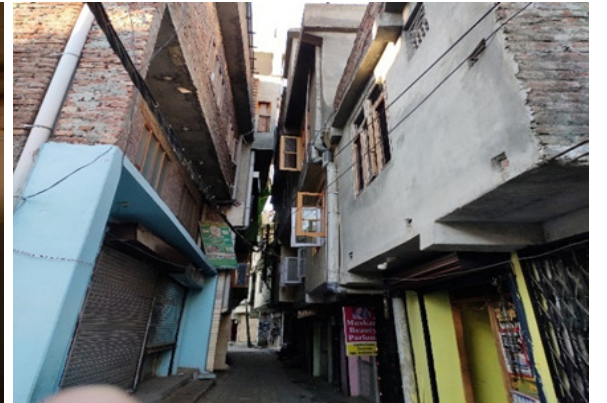
चम्बा के मुख्य बाजार में सैट-बैक्स छोड़े बिना किया गया निर्माण (05.12.2019)
