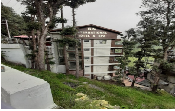
डलहौजी में भवन में अनुमत्य सीमा से अधिक मंजिलें बनाई गई हैं (03.10.2019)
